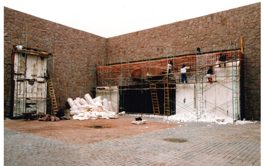
Instalación del Pórtico diciembre 1993—abril 1994 / december 1993—april 1994
