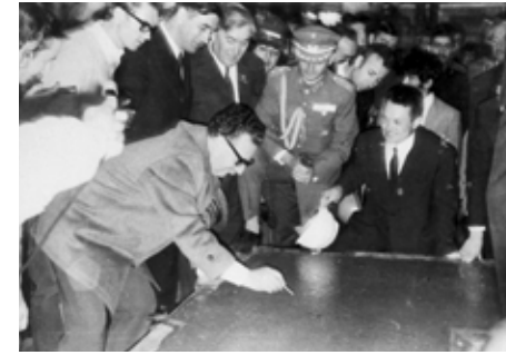
© Nalberto Salinas. El presidente Allende firma en el cemento fresco uno de los primeros paneles producidos por la fábrica KPD el día de la inauguración de las instalaciones.
